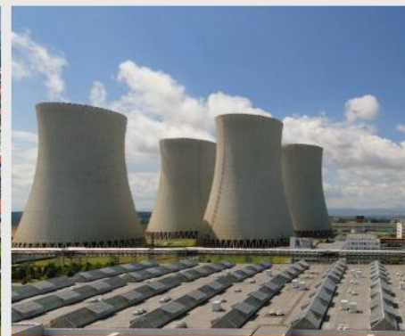
JADERNÁ ELEKTRÁRNA TEMELÍN
