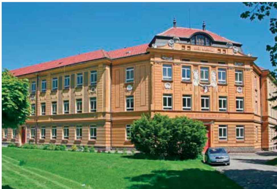
Původní fasáda školní budovy – začátek 21. století
