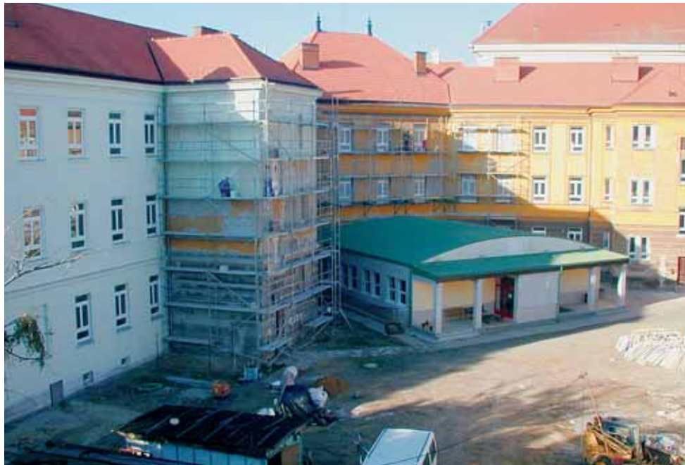
Oprava fasády v roce 2007
