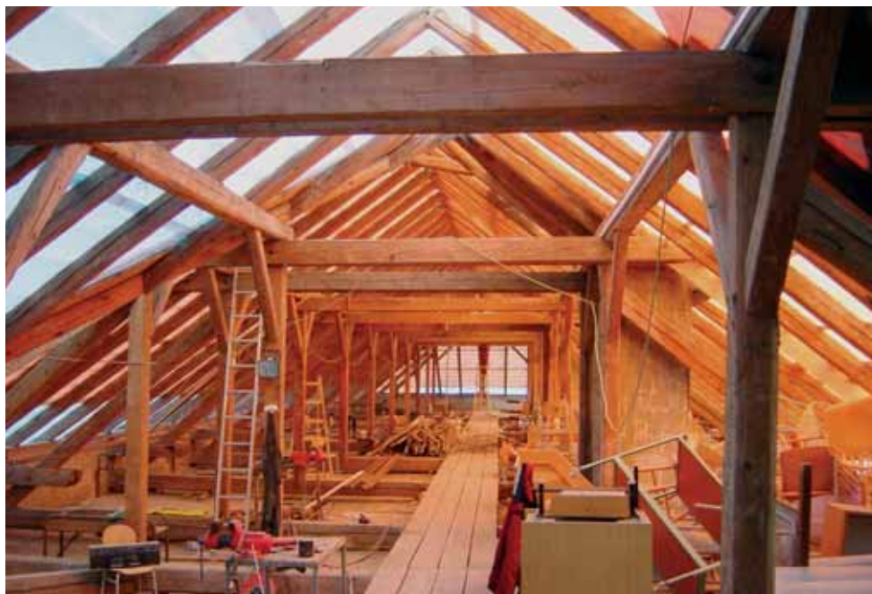
Oprava střechy v roce 2005
